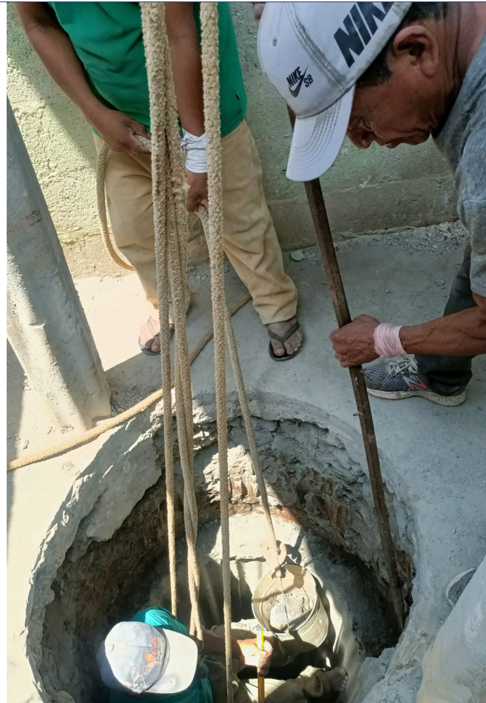
Rénovation du puits Nueva Esperanza.
